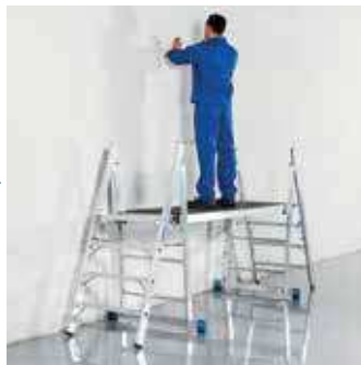
Mit 2 ProfiTritten und einer Belagbühne entsteht eine große Arbeitsfläche
